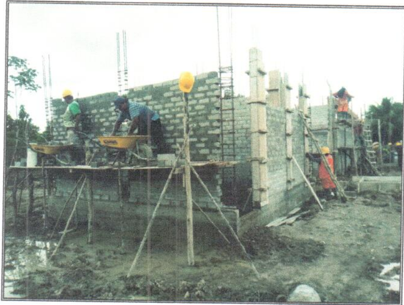
Vista N° 01: Asentado de ladrillo para aula, dirección y servicios higiénicos.
