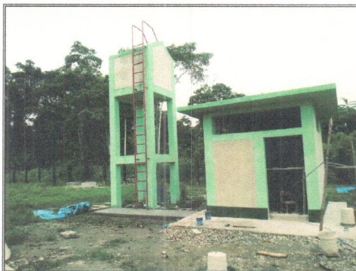
Vista N° 03: tanque elevado y caseta para pozo perforado.
