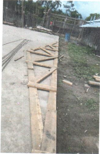
Vista N° 09: Armado de tijerales de madera.
