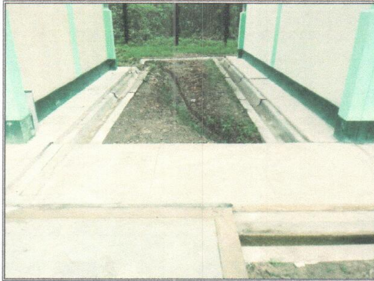
Vista N° 05: Cunetas para drenaje pluvial.
