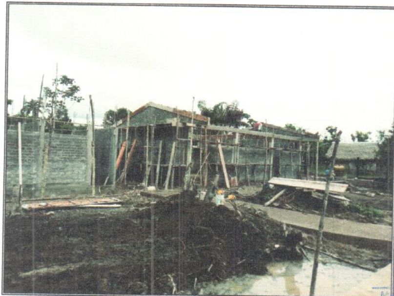
Vista N° 02: Aula, dirección y servicios higiénicos en ejecución.
