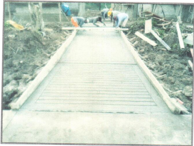
Vista N° 05: Vaciado de accesos peatonales.
