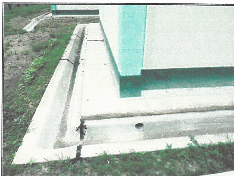
Vista N° 04: Cunetas para drenaje pluvial.
