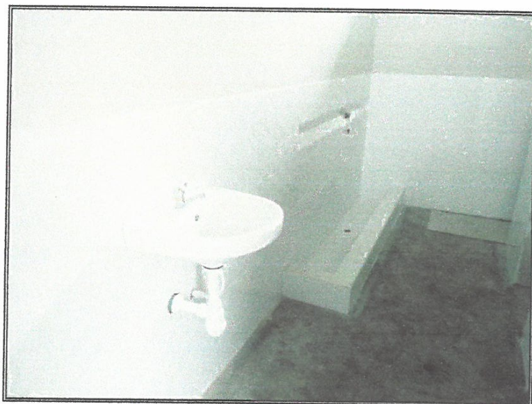
Vista N° 07: Interior de servicios higiénicos.
