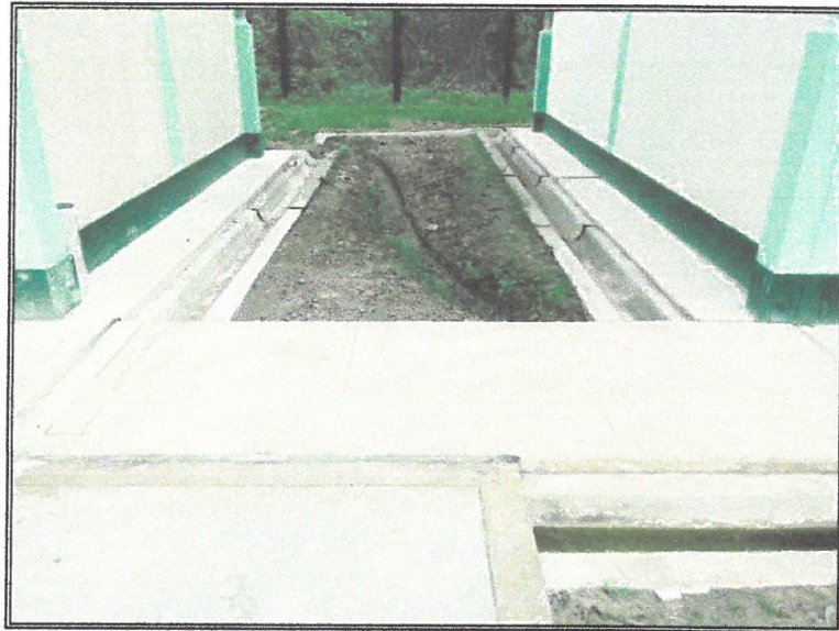
Vista N° 05: Cunetas para drenaje pluvial.
