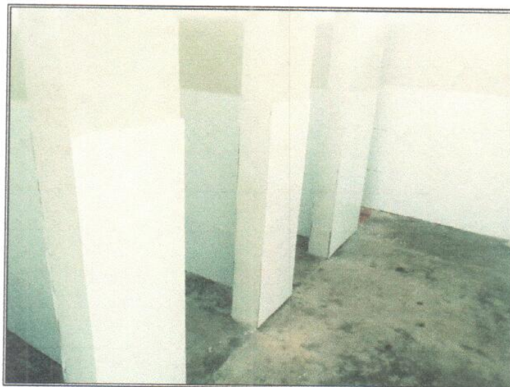
Vista N° 08: Interior de servicios higiénicos.
