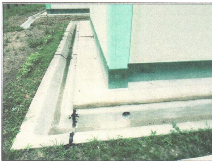
Vista N° 04: Cunetas para drenaje pluvial.
