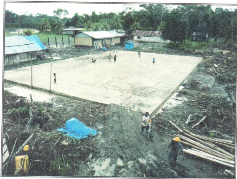
Vista N° 06: Losa deportiva culminada.
