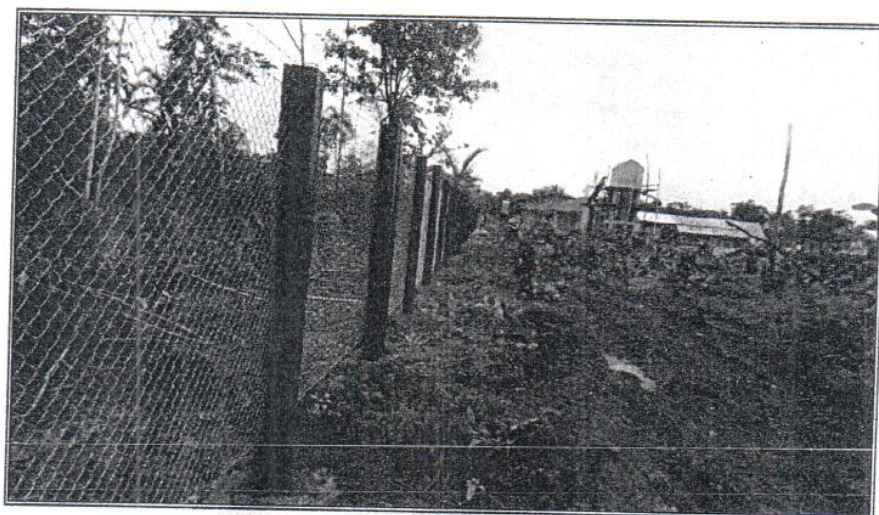
Vista N° 06: Cerco perimétrico con malla olímpica y postes de madera.
