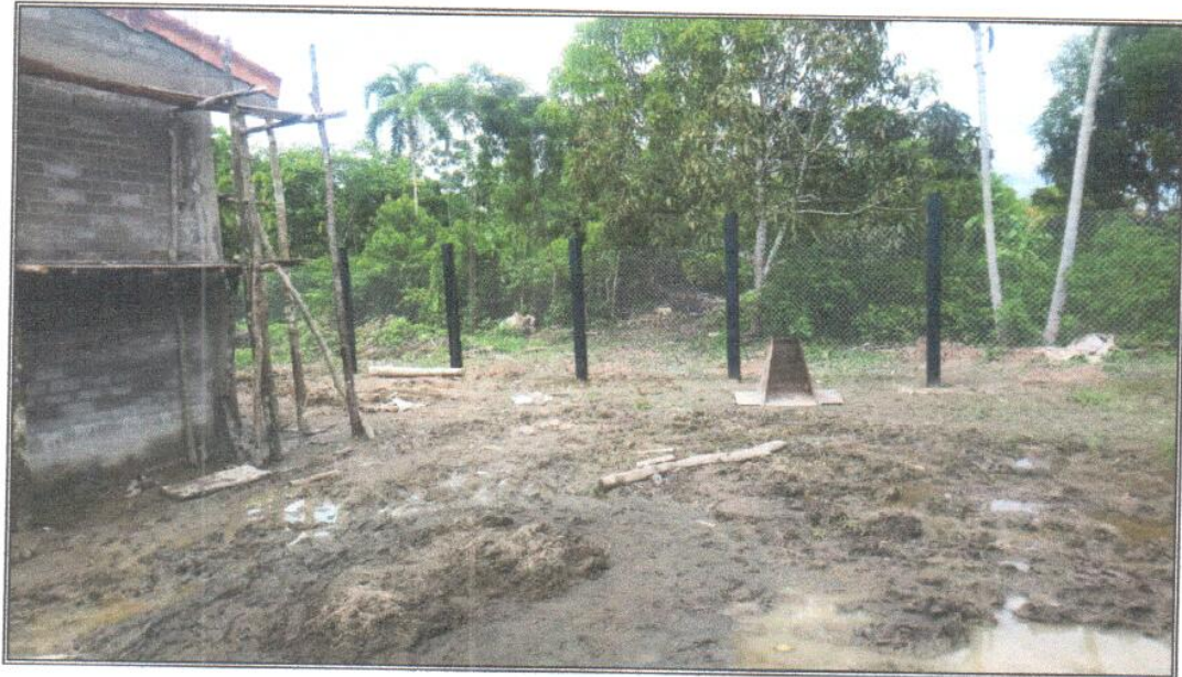
Vista N° 07: Malla olímpica adosada a postes de madera (cerco perimétrico).
