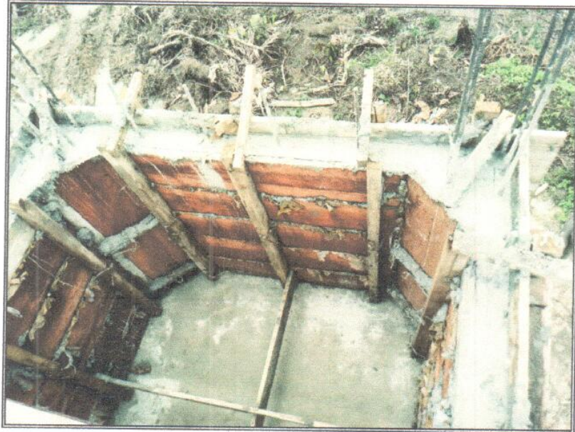
Vista N° 03: Vaciado de tanque elevado.
