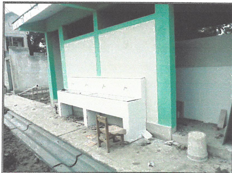
Vista N° 06: Exterior de servicios higiénicos.
