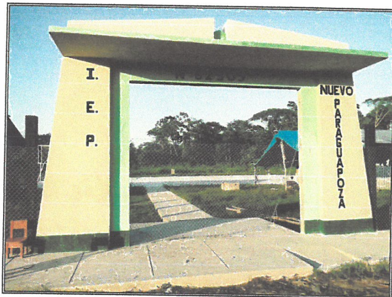
Vista N° 10: Pórtico de ingreso principal
