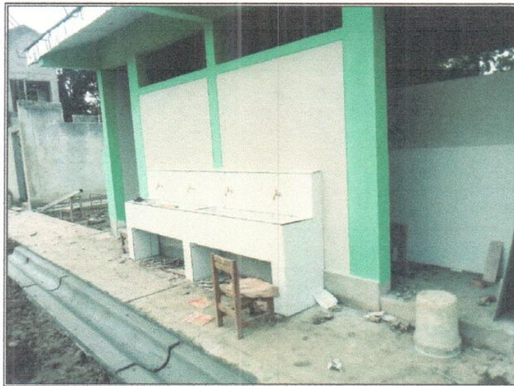
Vista N° 06: Exterior de servicios higiénicos.
